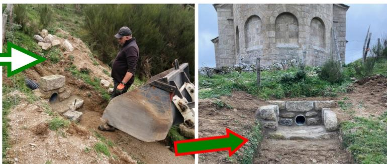
Sébastien a aussi réalisé différents travaux d'A.E.P. et de pluvial, rue Pied-De-Selle ou au moulin du Bayle notamment, avec le curetage de fossés et la pose de regards. Notre agent continue aussi le nettoyage régulier des regards et des aqueducs de la commune.
