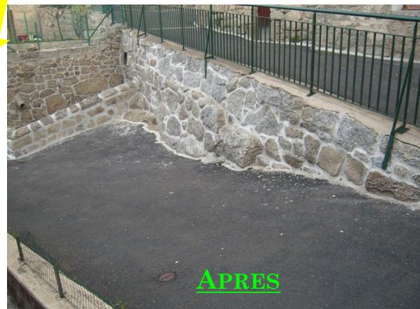
**AQUEDUC :** Afin de canaliser les eaux de ruissellement, à la fois de la route de saint Denis et de l'ancienne route, des travaux ont été réalisés au niveau de l'aqueduc. Par la même occasion, les joints du mur ont été restaurés.
